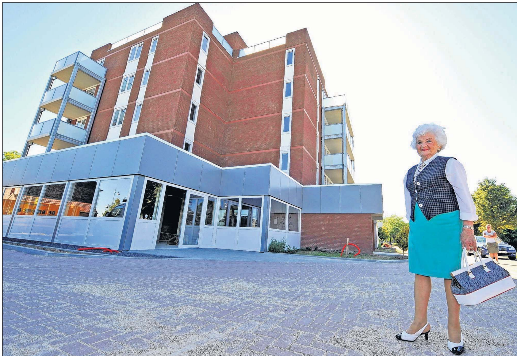
Corry Vermeer is tevreden over het resultaat van de renovatie en de nieuwe
